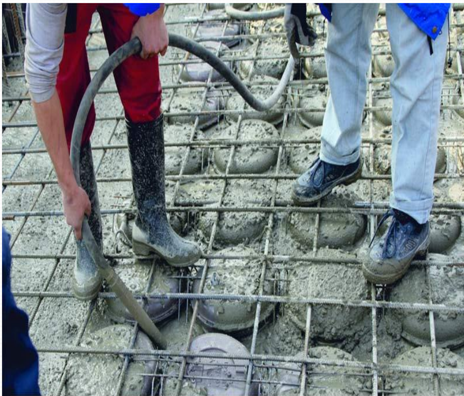
20.09.2012 г. ЗАО "ГК ИНЖГЛОБАЛ" возводит облегченные монолитные железобетонные перекрытия с применением объемных пустотообразователей Sobiax при строительстве ЖК "Лесной уголок". МО, Химки, ул. Опанасенко, д. 5 - Ленинский проспект, вл. 33-35.
